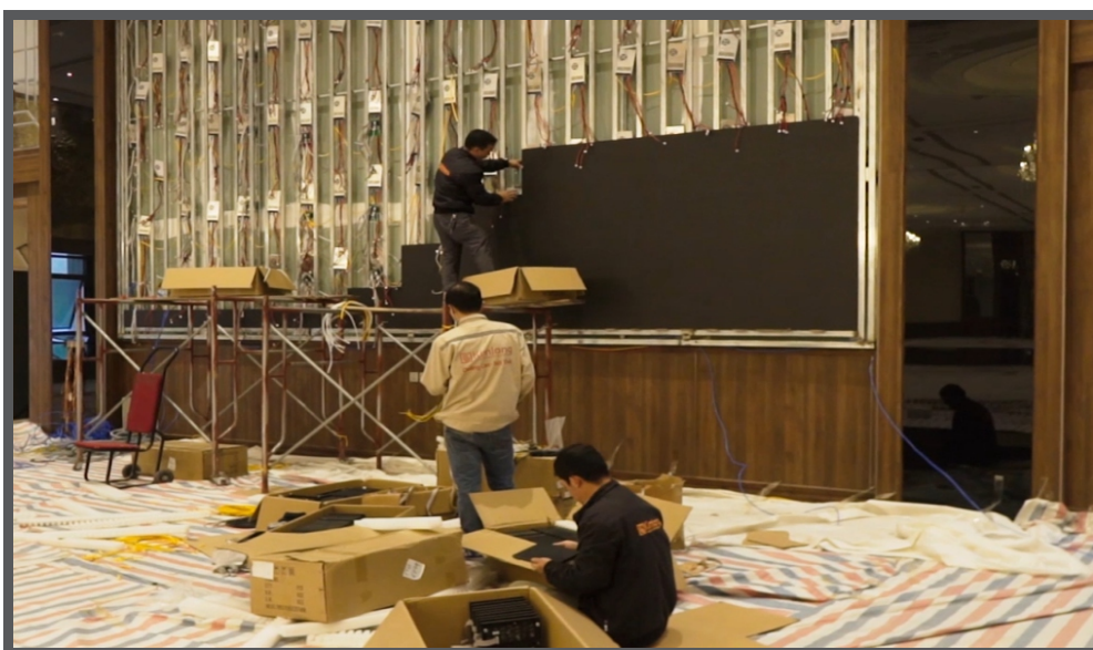
Thi công màn hình LED tại hội trường
